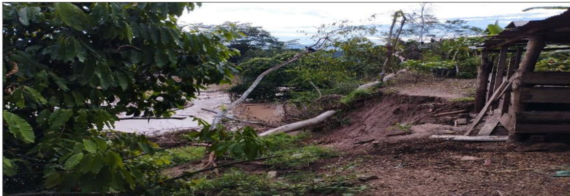
FIGURA N°03: TRAMO CRÍTICO EN EL RÍO SAPOSOA, DONDE SE PRODUJO SOCAVAMIENTO DE LA RIBERA GENERANDO LA CAIDA DE ARBOLES, AFECTANDO A LAS VIVIENDAS ALEDAÑAS Y ÁREAS ADE CULTIVO.
