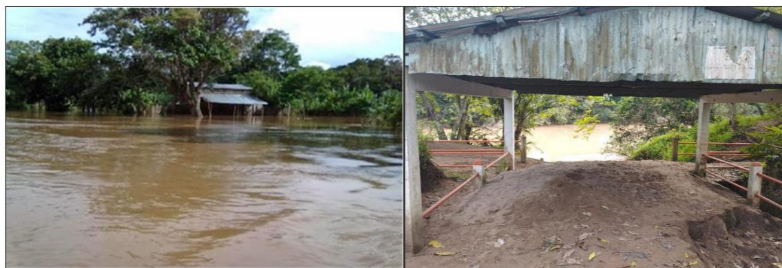
FIGURA N°02: TRAMO CRÍTICO EN EL RÍO SAPOSOA, MIRADOR Y PUERTO CANTORCILLO INUNDADO EN TIEMPOS DE MAXIMAS AVENIDAS, Y POR LA VELOCIDAD DEL AGUA VIENE EROSIONANDO EL TALUD DE LA RIBERA.
